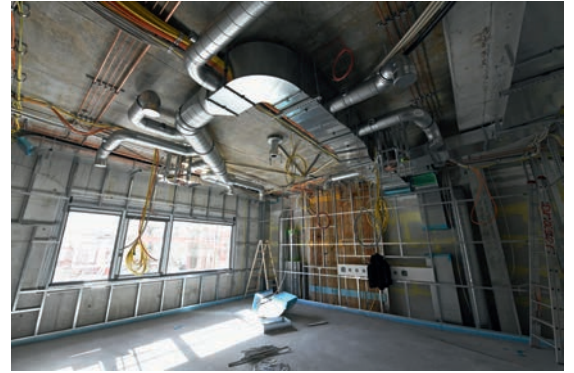
Einer der neuen OP-Säle noch im Rohbau.
