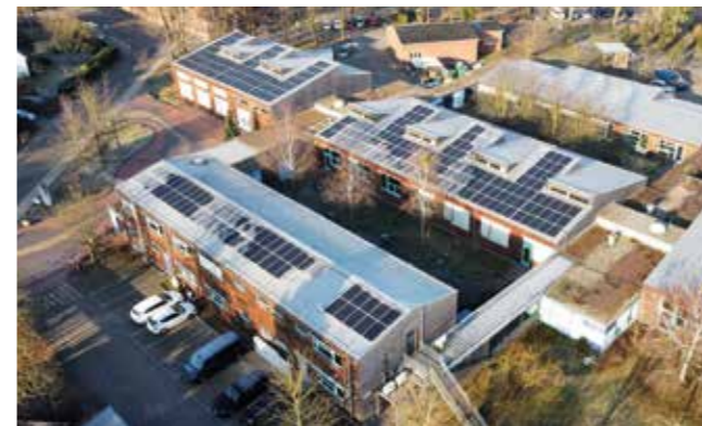
600 qm Dachfläche produzieren nachhaltigen Strom für die Oberlin Werkstätten auf der Insel Hermannswerder
